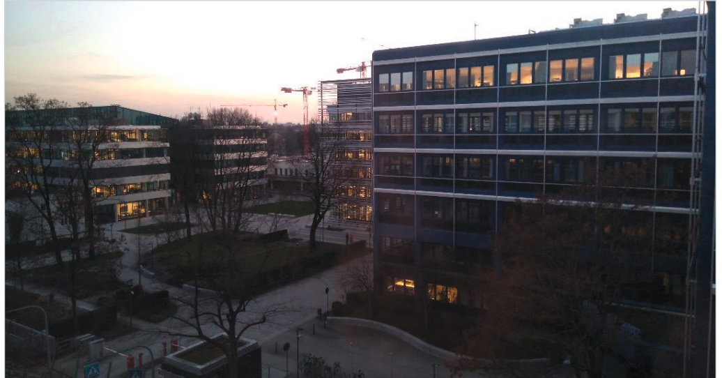
그림 24: 카메라 “전송 중” 플래시 no window / no 반사율
